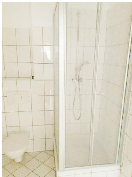
Badezimmer mit Dusche
