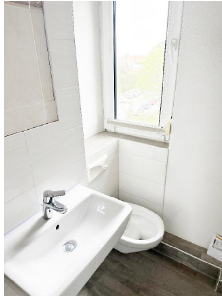
Tageslichtbad mit Raumsparwanne, Toilette, Waschtisch und Handtuchheizkörper
