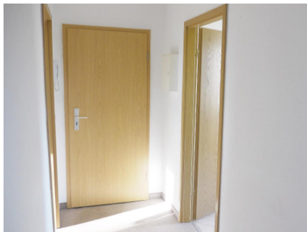
Erdgeschoss links - Flurbereich
