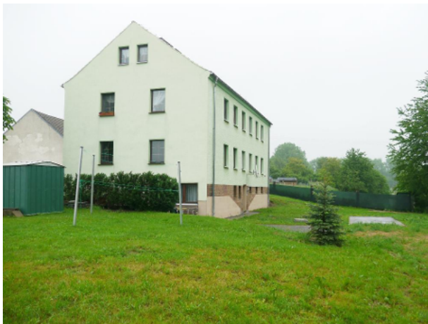
Außenansicht von Gartenseite
