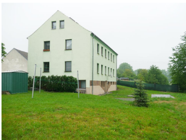
Außenansicht von Gartenseite
