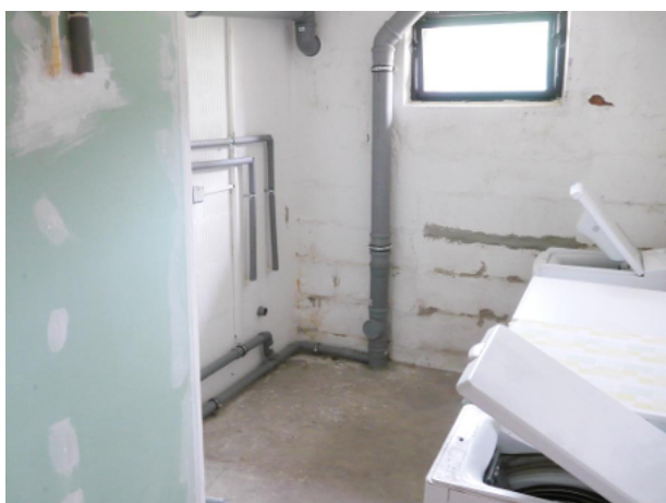
Kellergeschoss - Waschmaschinenraum für Mieter
