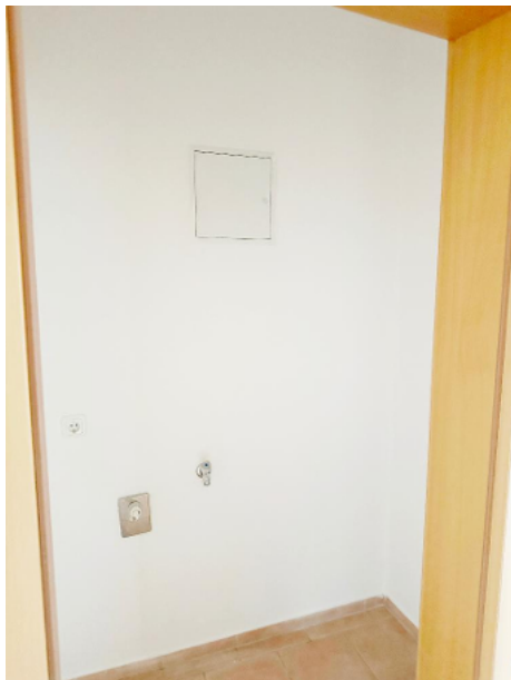
Abstellraum mit Waschmaschinenanschluss
