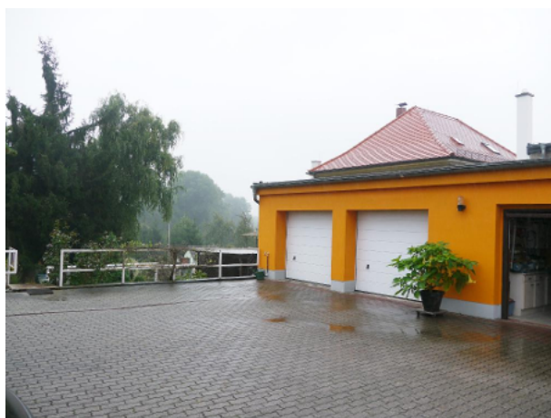
Nebengebäude mit Garagen
