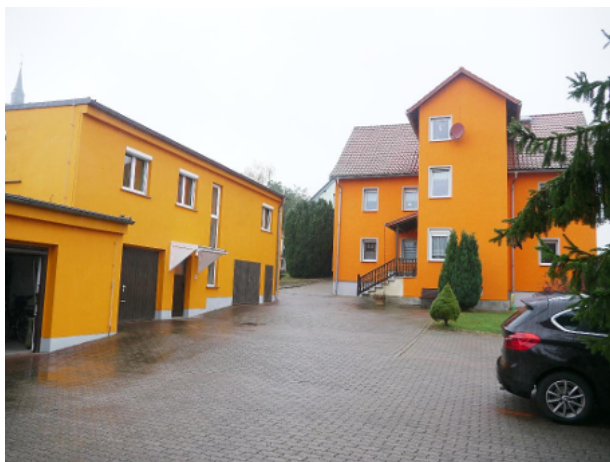
Hofansicht mit Haupt- und Nebengebäude
