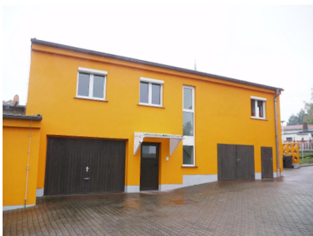
Nebengebäude mit Garagen
