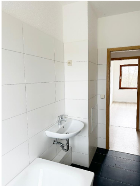
Tageslichtbad mit Wanne, WC und Waschtisch und Blick Richtung Flurbereich
