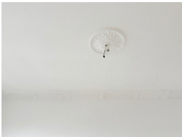
Stuckdecke im Schlafzimmer
