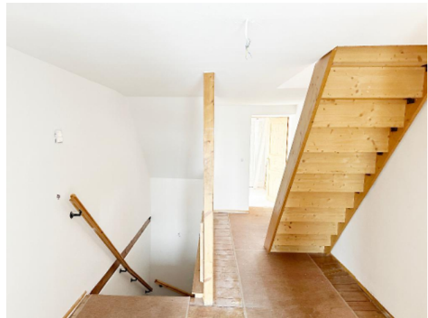
Flurbereich mit Blick zur Treppe Richtung Wohnungseingangstür nach unten und Treppe zum oberen Wohnbereich
