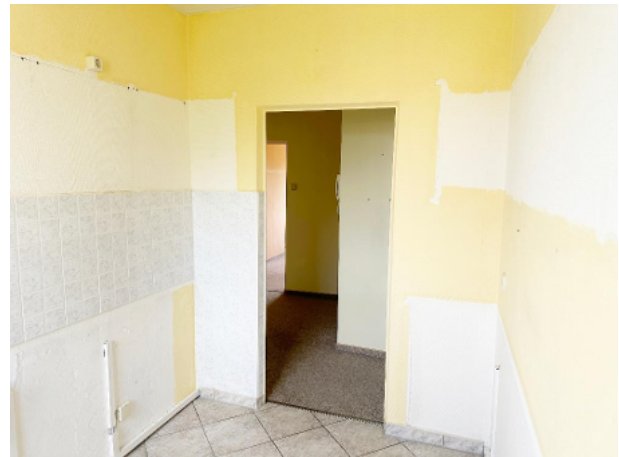
Küche mit Blick Richtung Flurbereich
